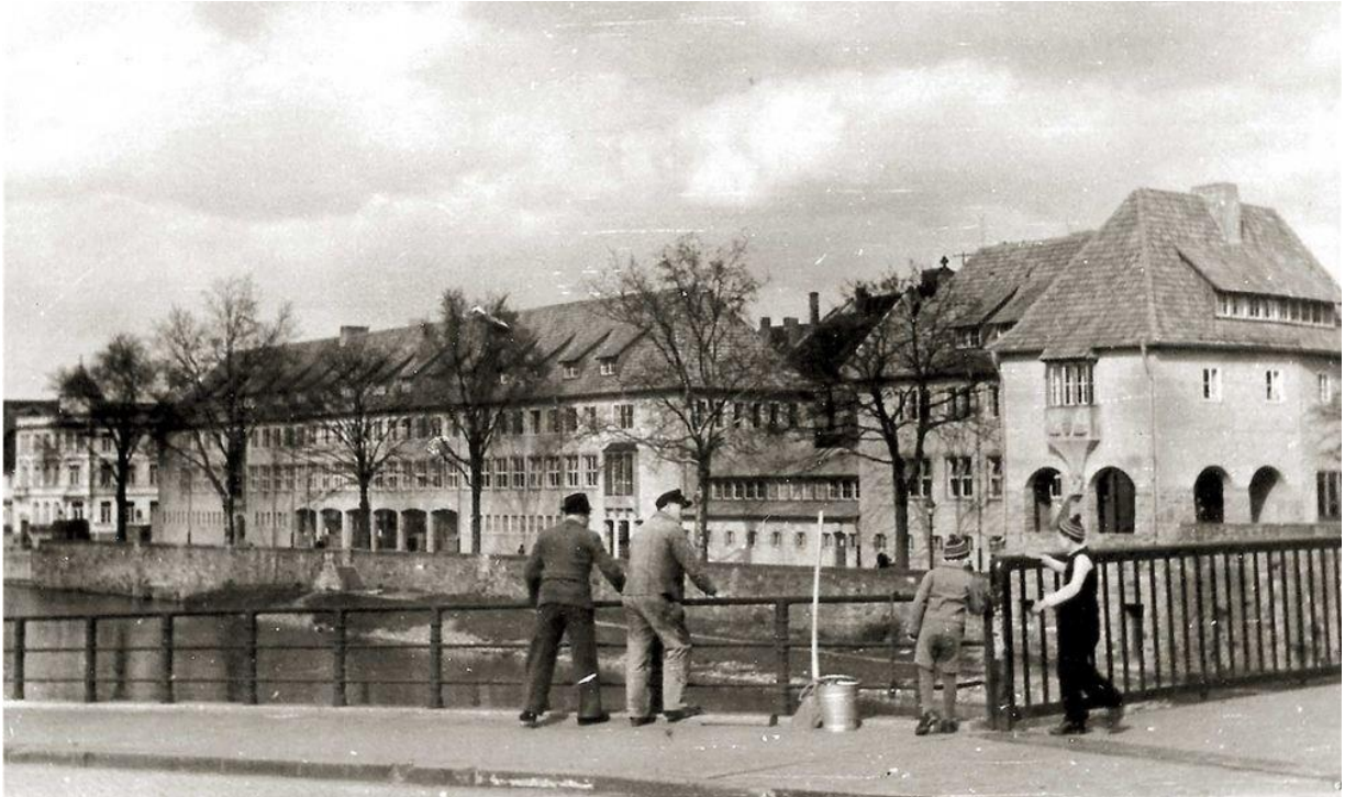
Der Neubau am Langen Wall – heute Elisabeth-Selbert-Schule – war einst Sitz der HLA
